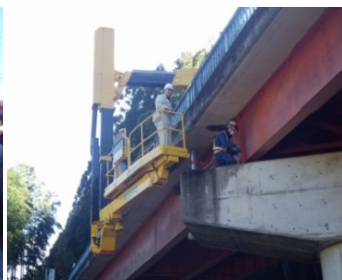
写真2 橋梁点検車による調査作業 橋梁点検車（左）と橋脚調査作業（右）
