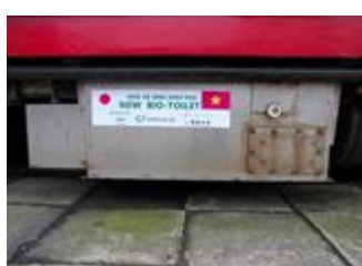
図2. ベトナム国鉄車両に設置したバイオトイレ
