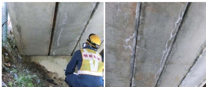
写真1 橋梁調査 桁端部・橋台(左)と主桁(右) 明星大学橋梁調査プロジェクトスタッフ
