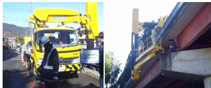
写真2 橋梁点検車による調査作業 橋梁点検車(左)と橋脚調査作業(右)
